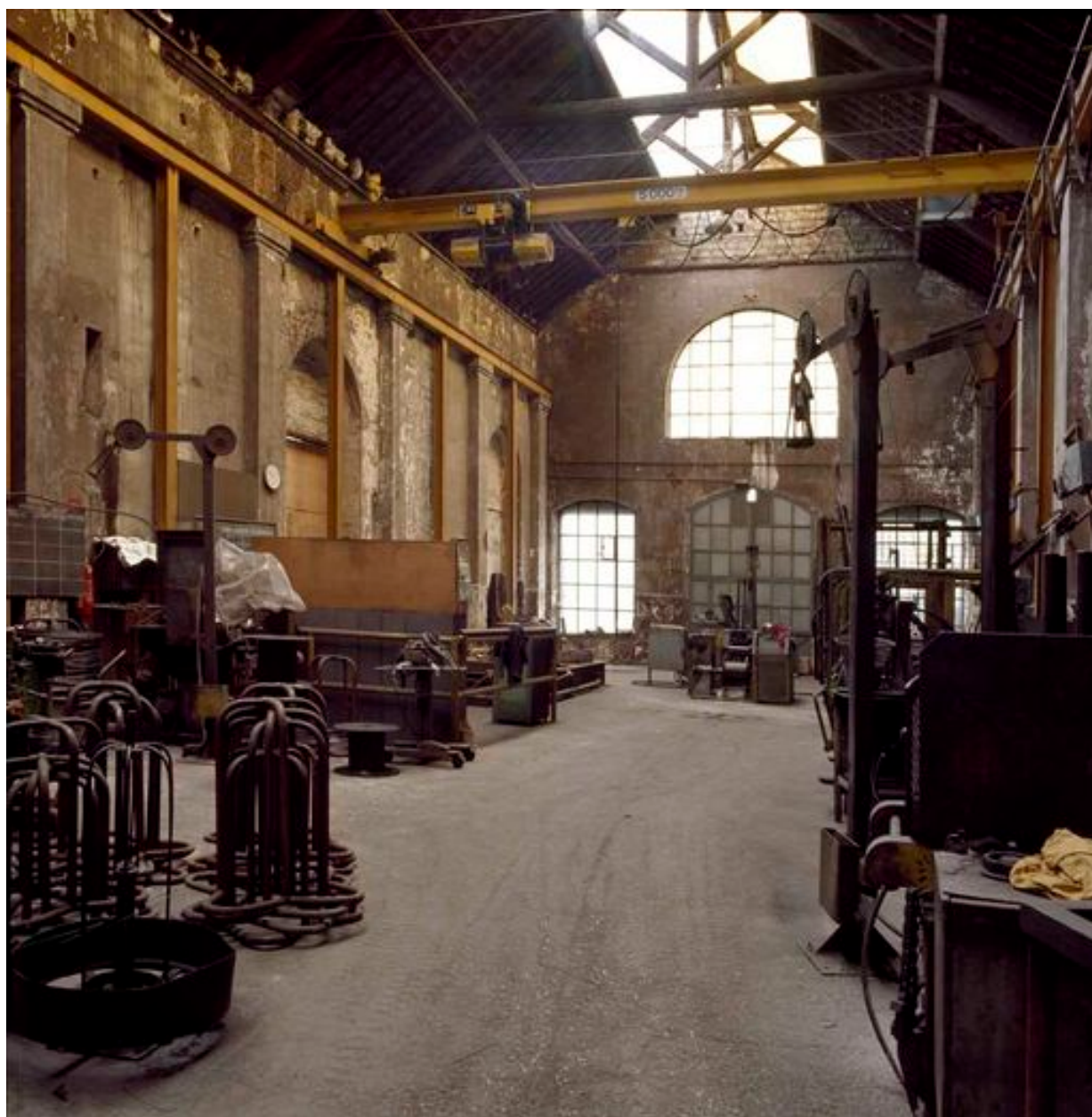
Intérieur d'une halle abritant les fours et la petite tréfilerie, construite au cours de la décennie 1880.
