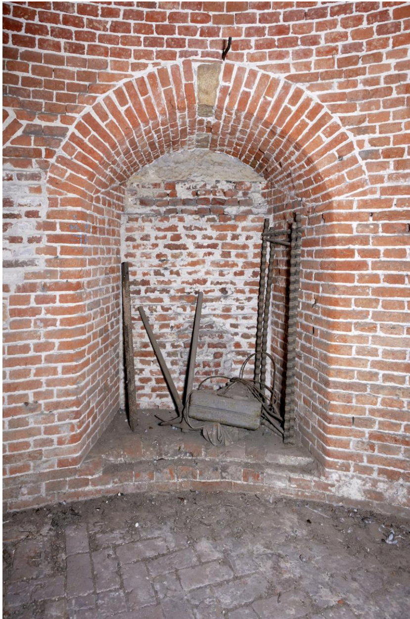
Niveau principal (R+1). Niche de tir sud-ouest comblée.
