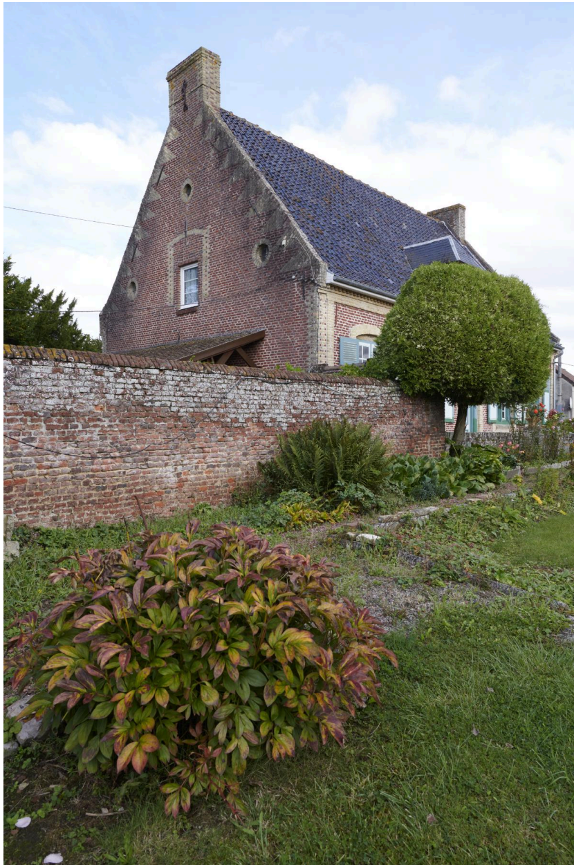
Détail du pignon ouest.
