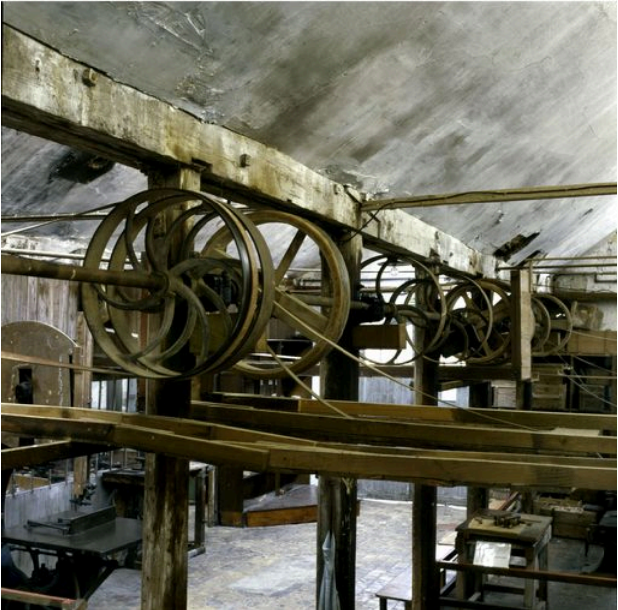
Détail des poulies et courroies alimentant les différentes machines de l'atelier.
