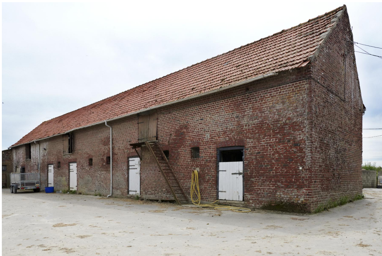
Bâtiment au sud de la ferme.
