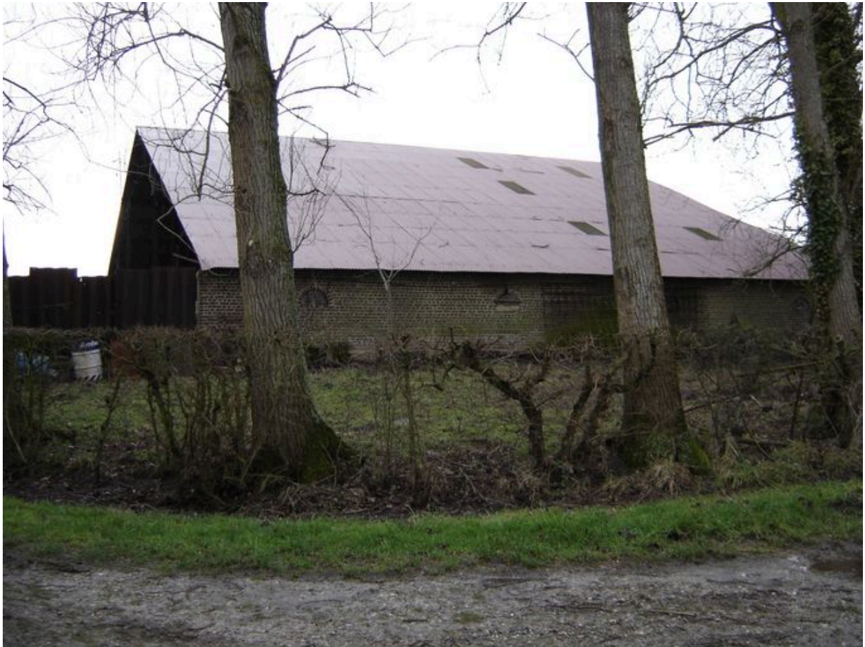
Vue sur les étables (à l'ouest de l'ensemble principal).
