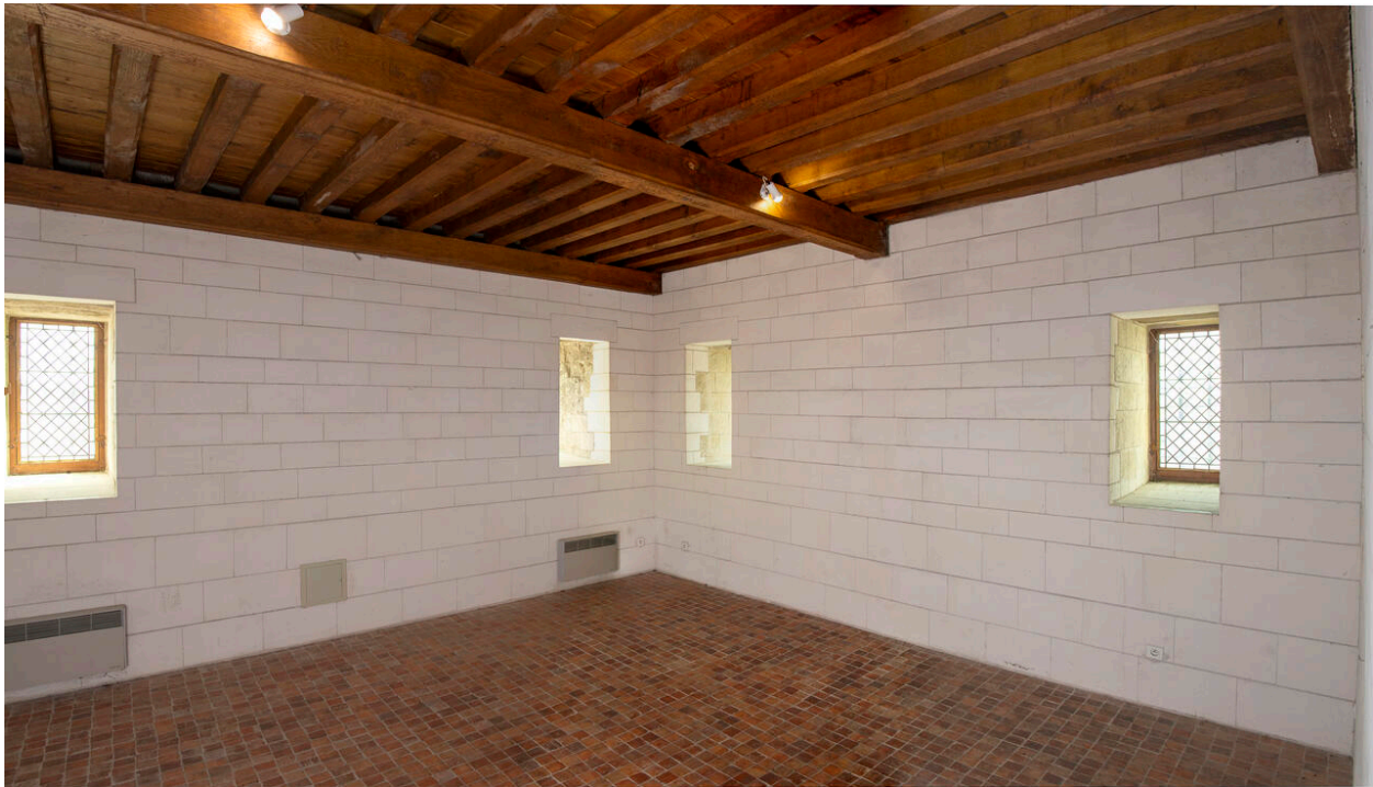
Vue générale de la salle des gardes datant des années 1980.
