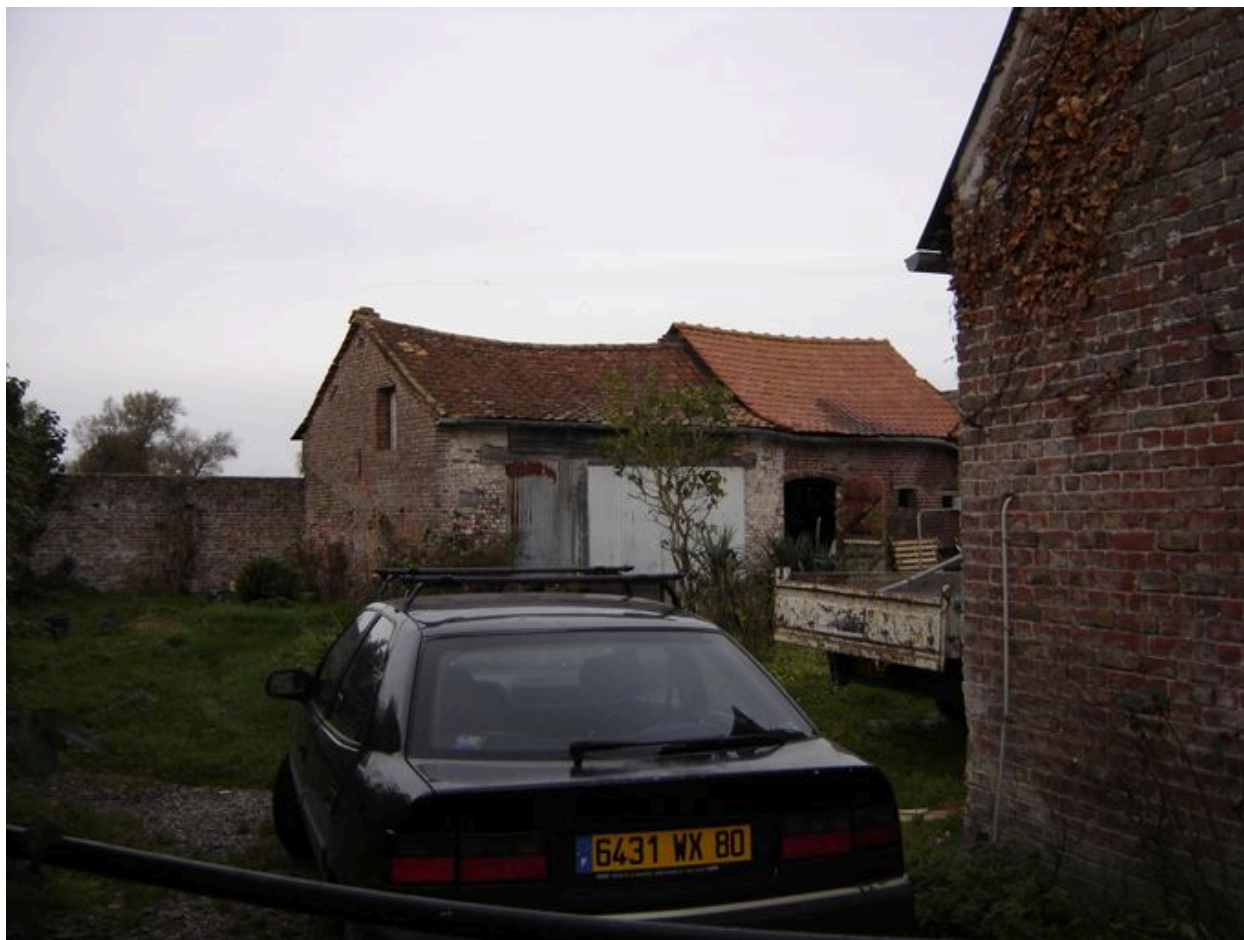
Vue des dépendances en fond de cour.
