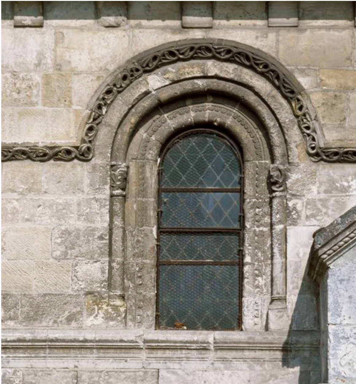
Baie haute de l'élévation sud.
