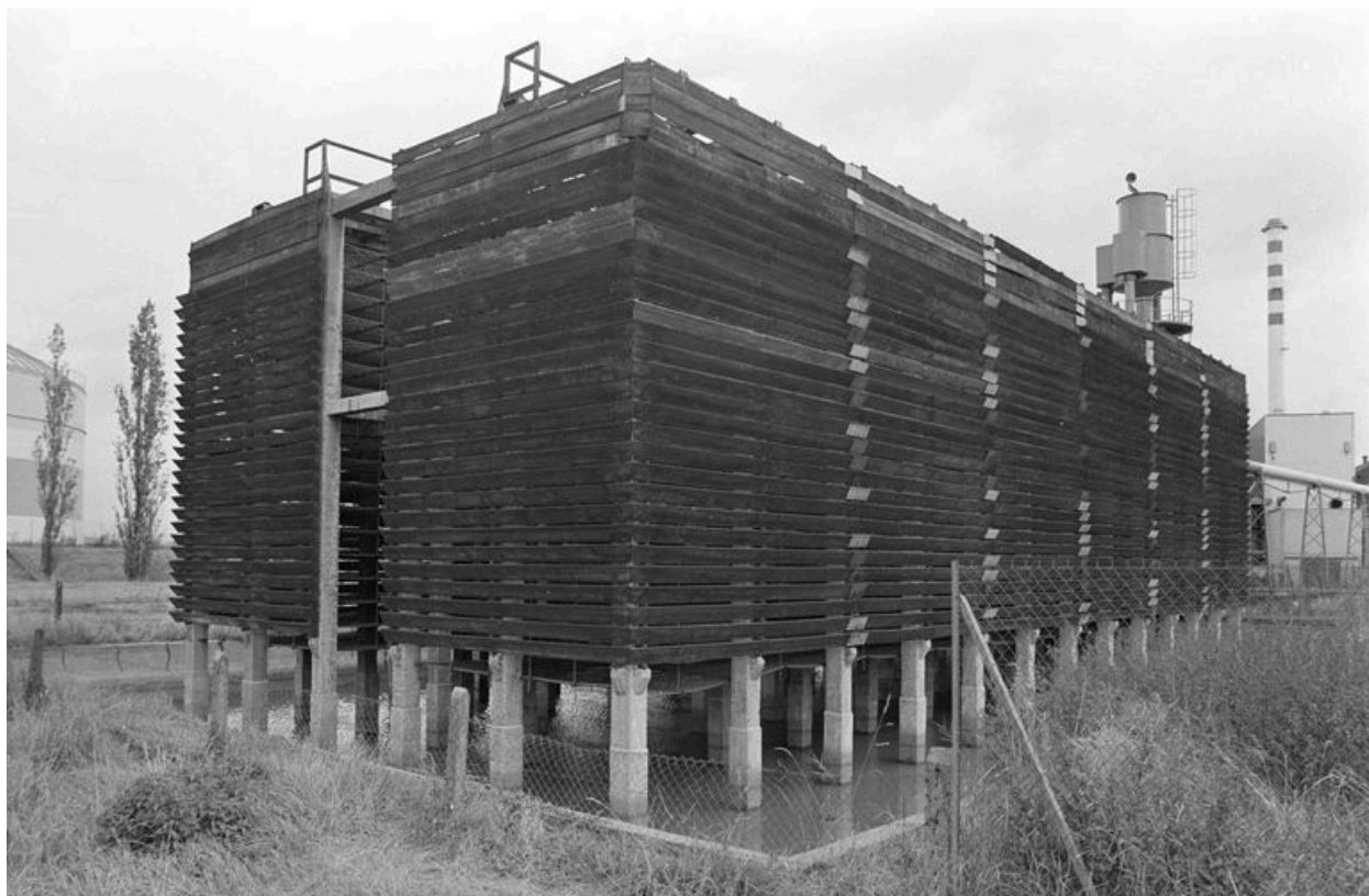
Réfrigérant : vue générale.
