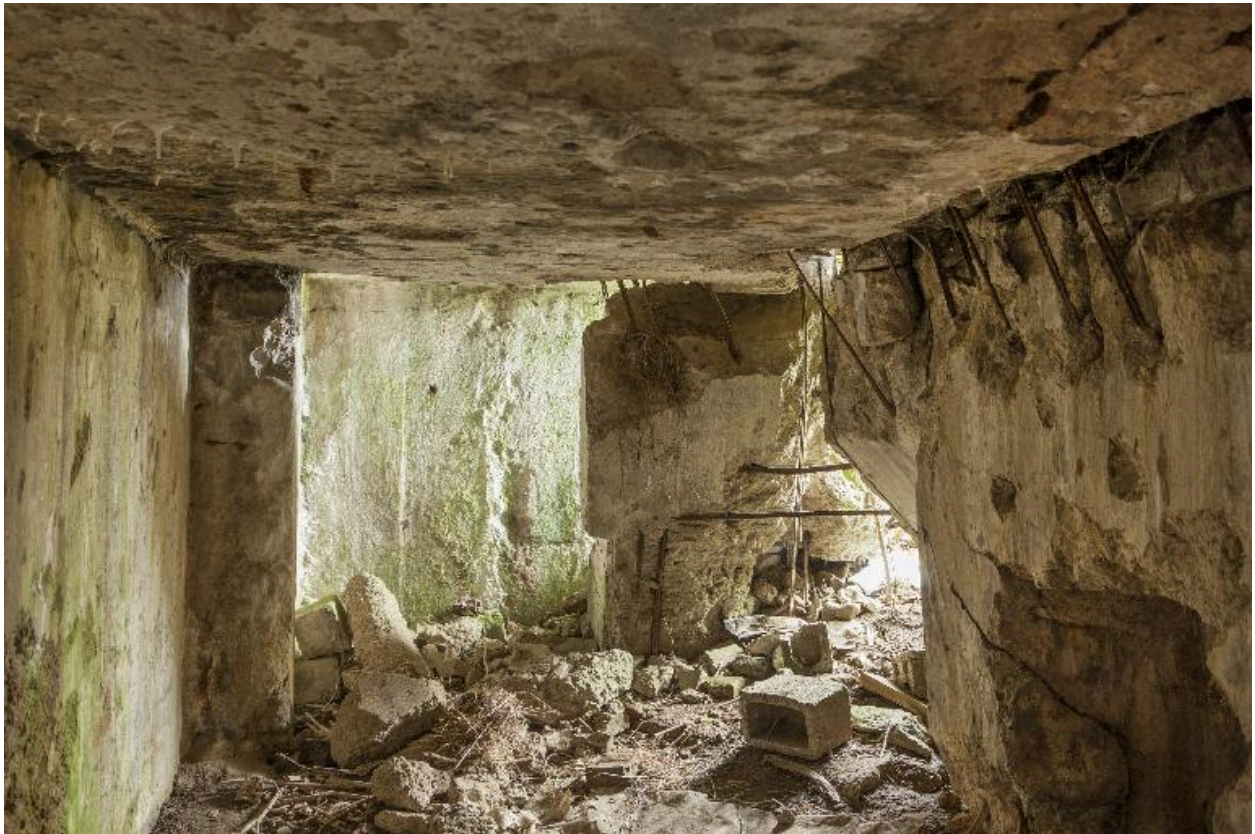
Casemate b. Casemate Vue intérieure, vers l'entrée.
