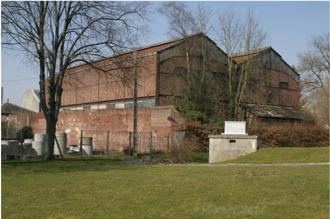
Les entrepôts vus depuis le sud-est.
