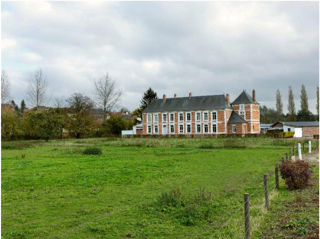
Vue de situation, depuis le nord.
