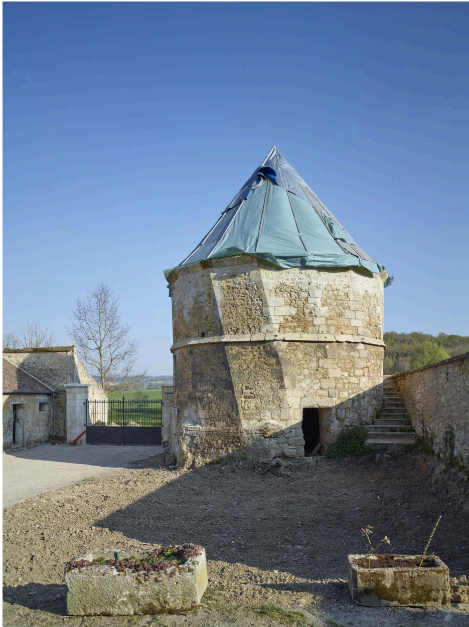
Vue générale du colombier prise depuis le nord.
