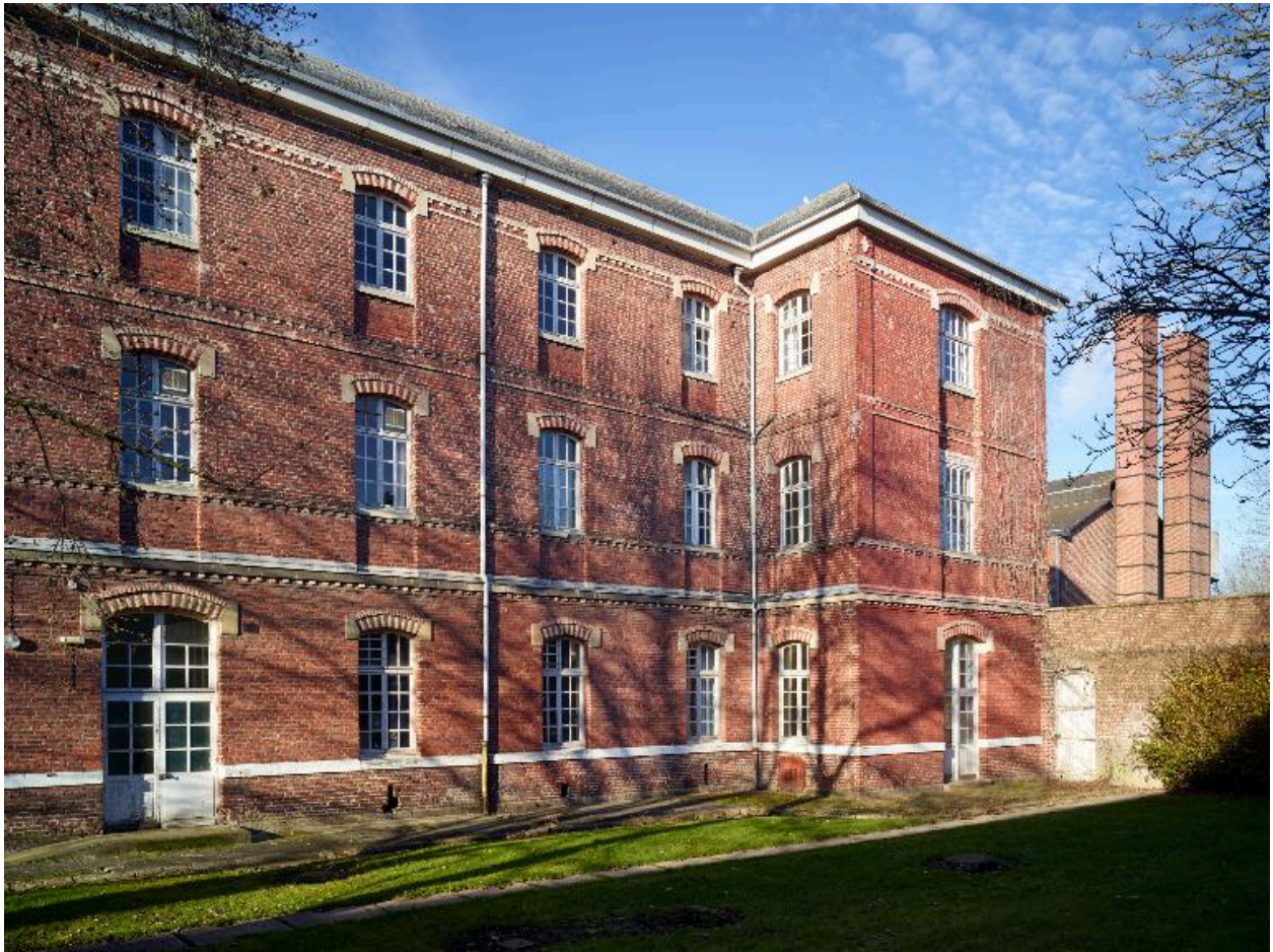
Bâtiment d'hospitalisation dit pavillon 6, élévation antérieure donnant sur le jardin, moitié droite, vue de trois quarts gauche.
