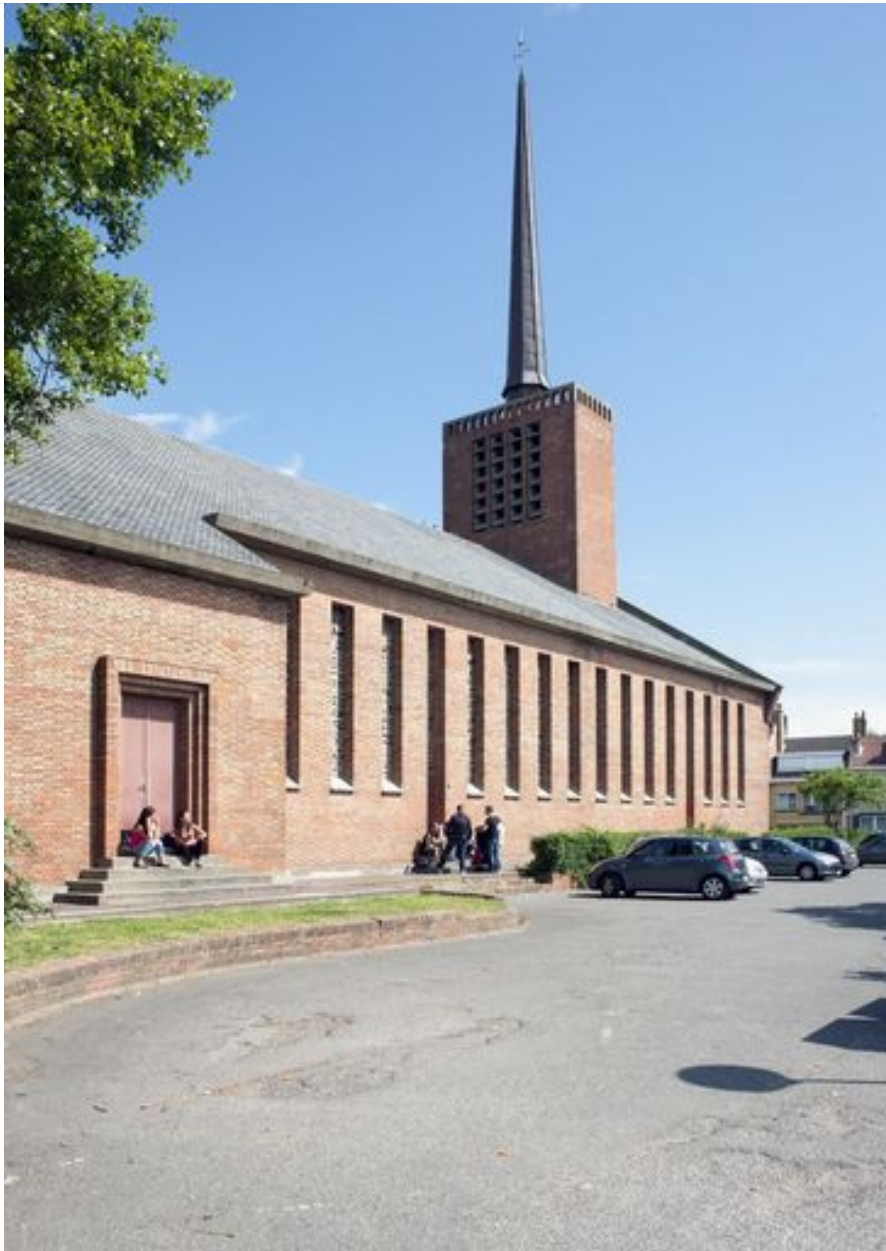
Vue arrière du flanc gauche.
