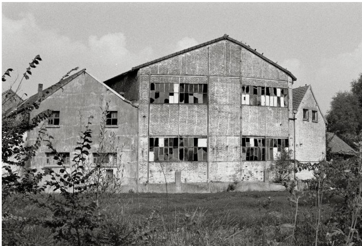
Ateliers de fabrication, vue postérieure.
