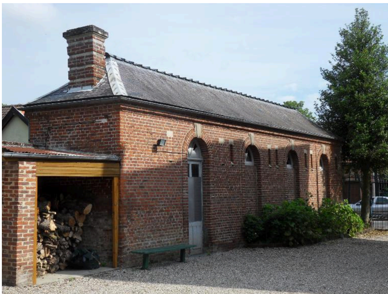
La remise de la pompe à incendie.
