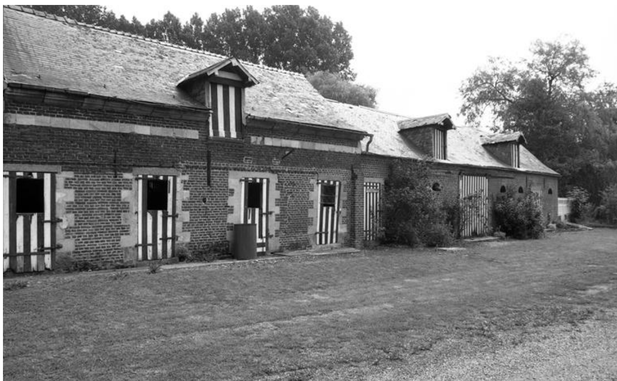
Vue de l'élévation sur cour des étables.
