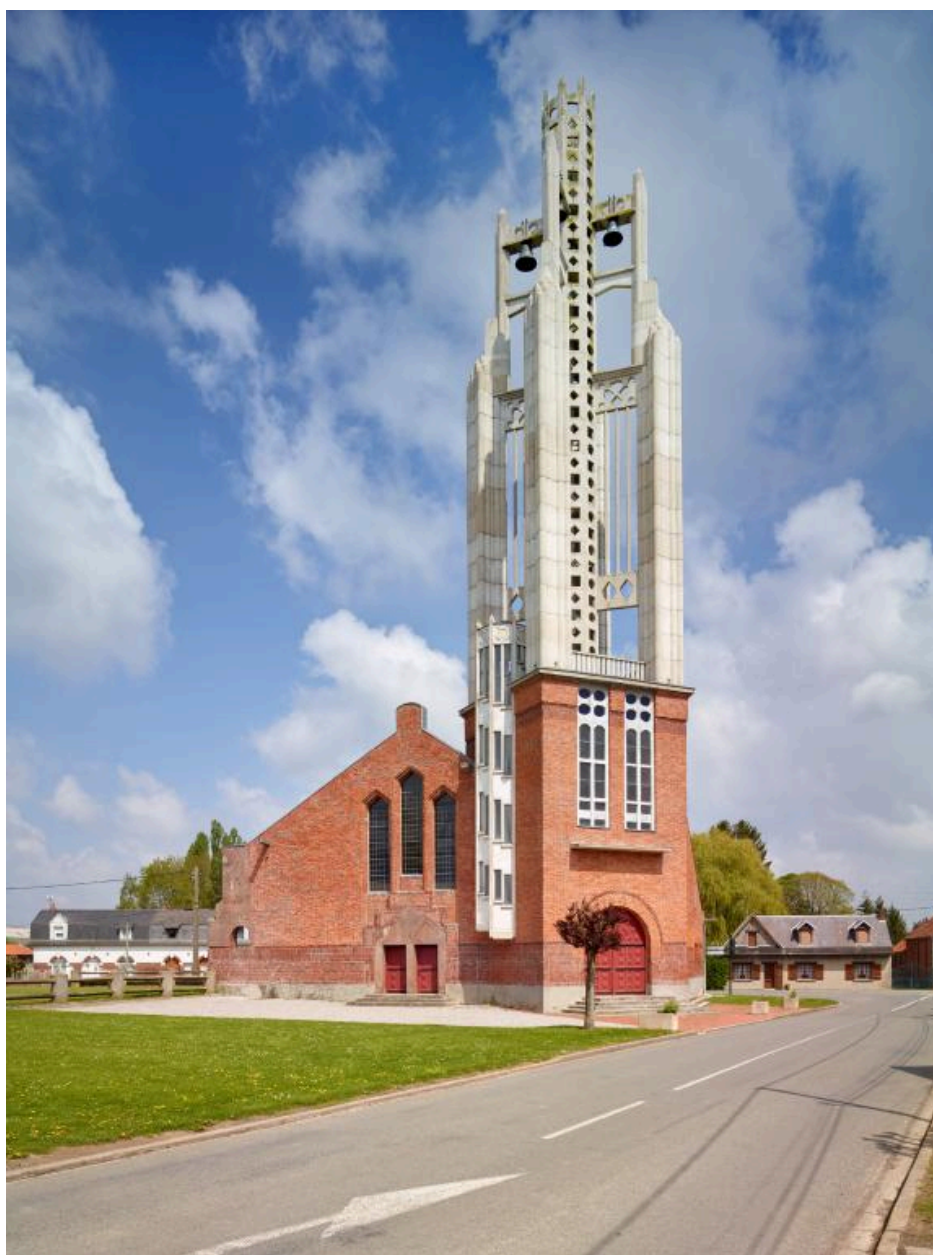
Vue vers le nord-est.
