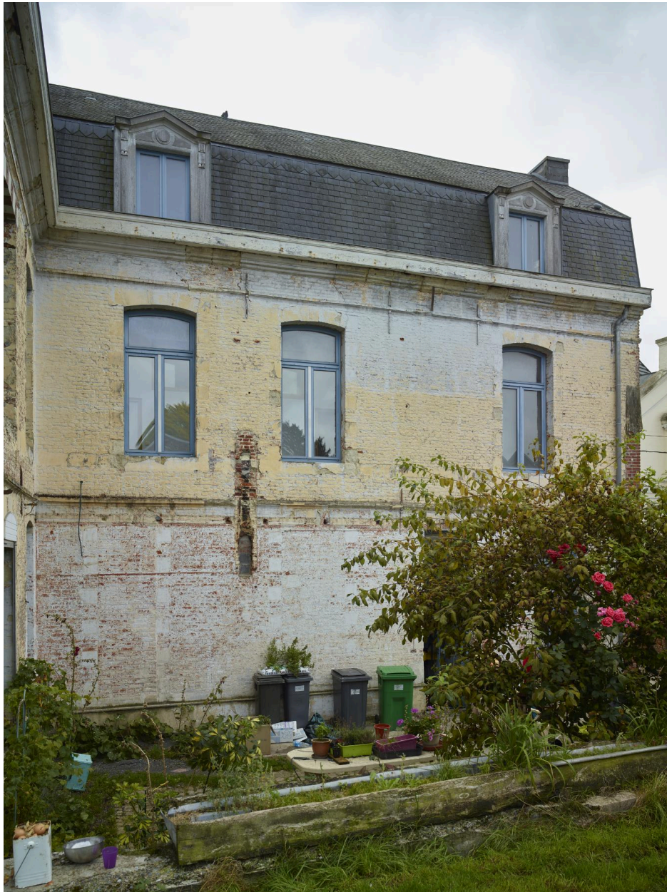
Ancienne école privée : façade arrière de l'aile principale.
