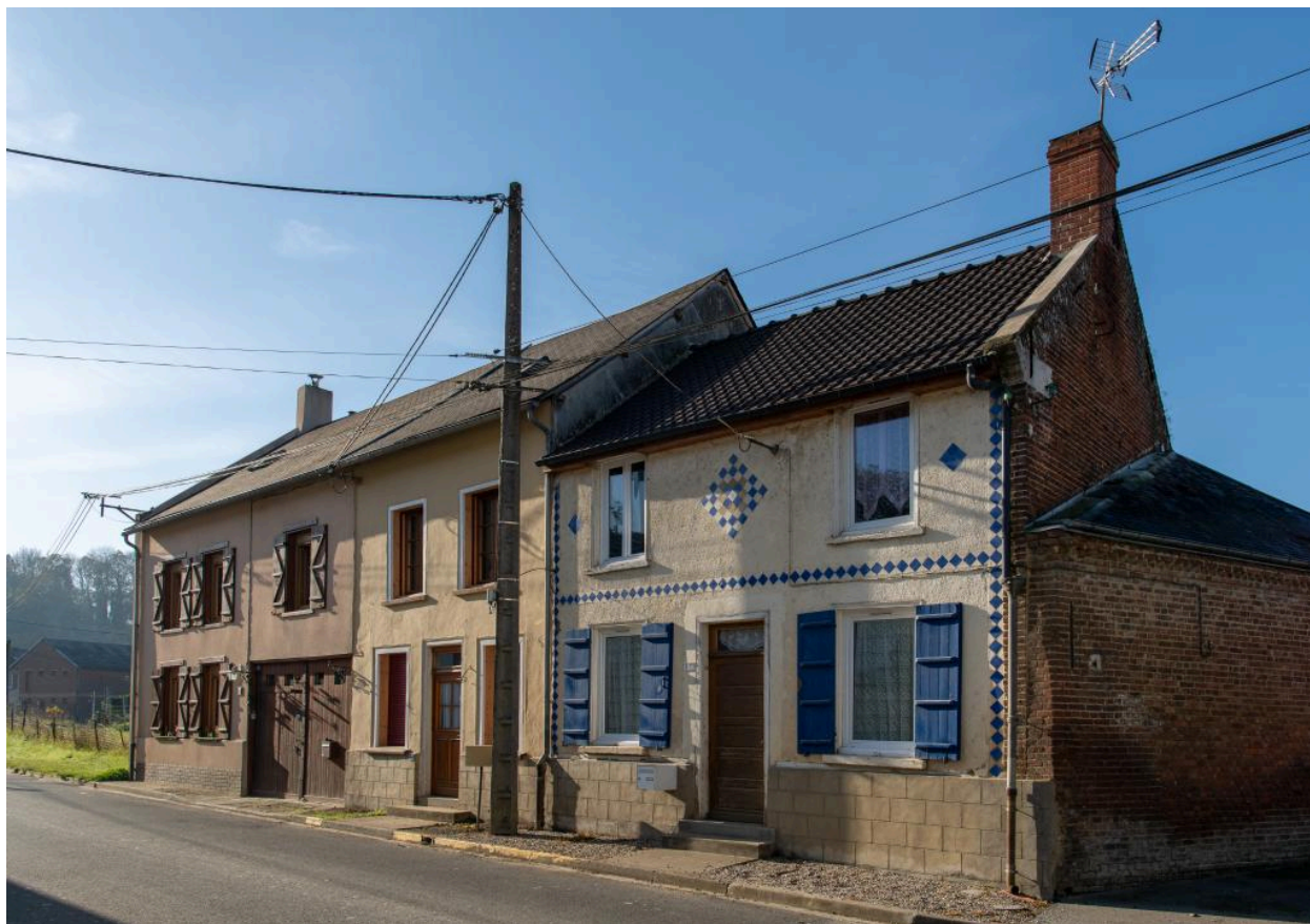
Anciens commerces ou maisons d'artisans, n°39 à 35 Grande Rue, vue depuis le nord-est.
