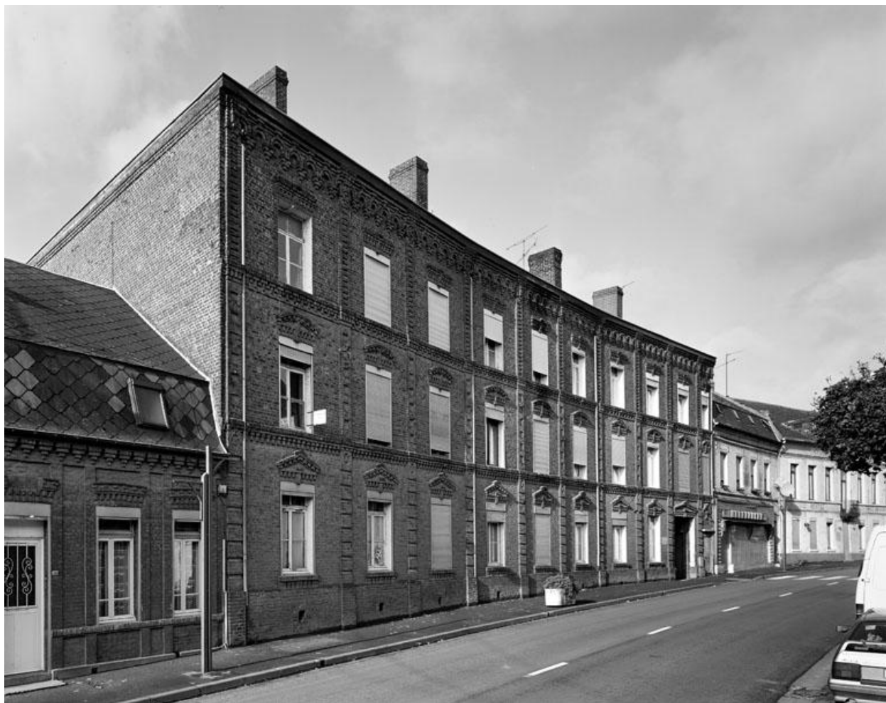
Vue de la façade sur rue.
