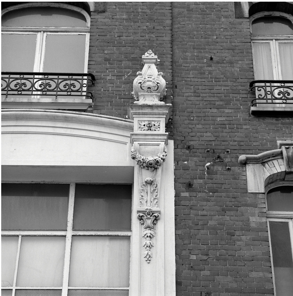
Élévation antérieure. Travée centrale. Amortissement en pierre.
