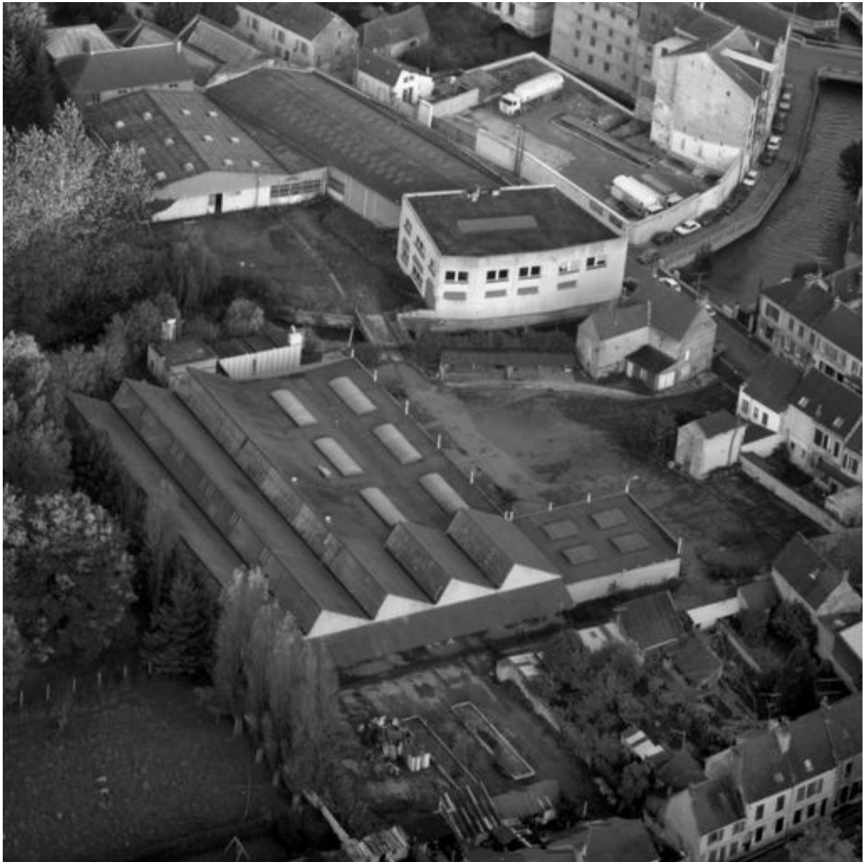
Vue aérienne de l'usine en 1993.
