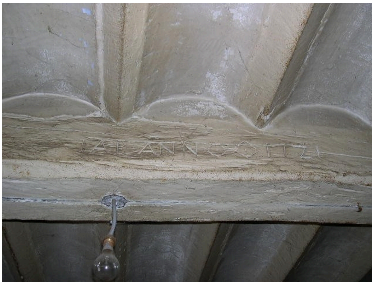
137, rue de la Caisse, poutre datée 1721.
