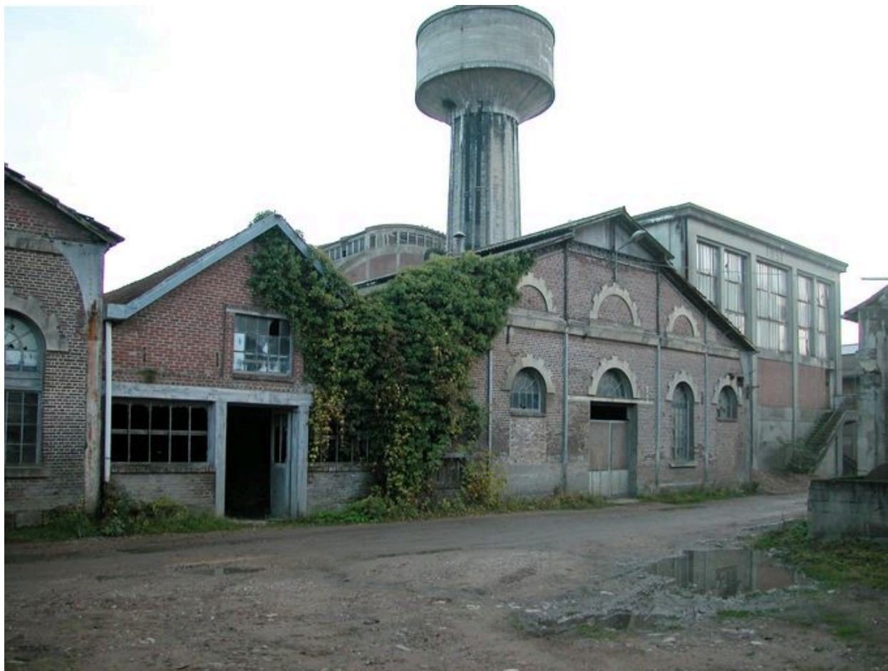
Façade nord de la blanchisserie et de l'atelier de teinture, avec la chaufferie à l'arrière plan.
