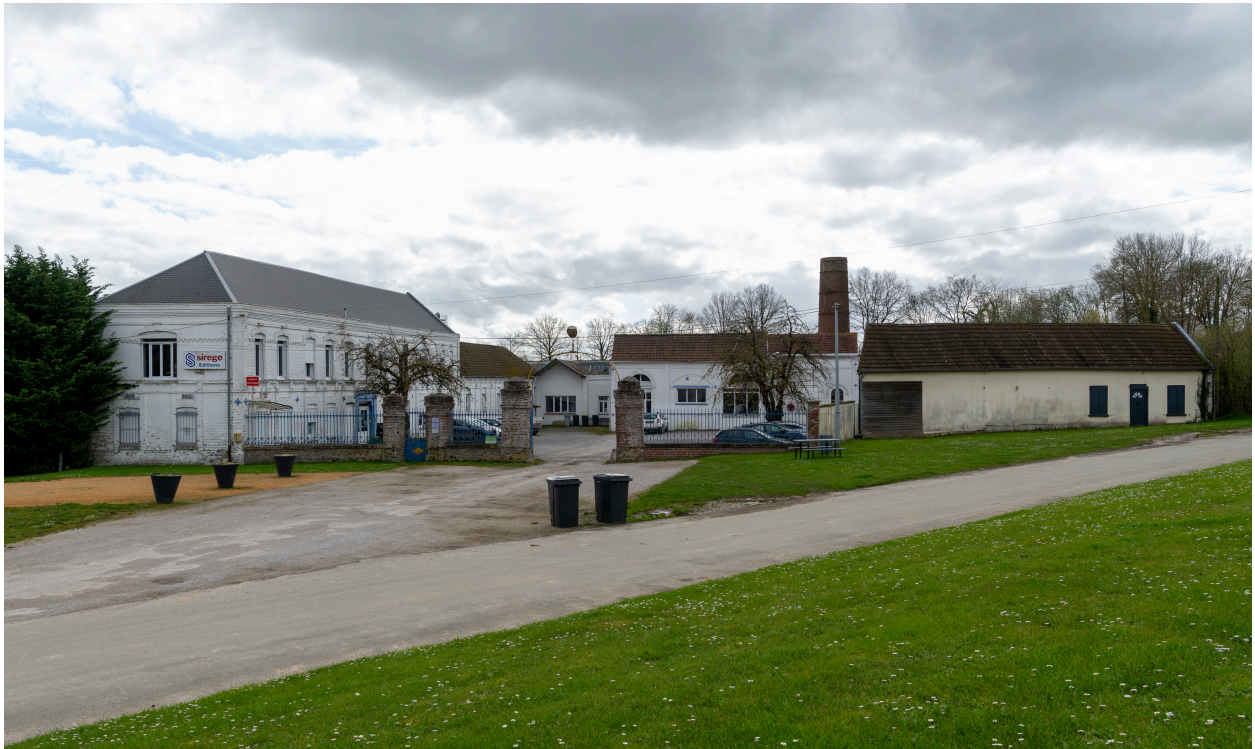
Vue générale de l'usine depuis le nord.
