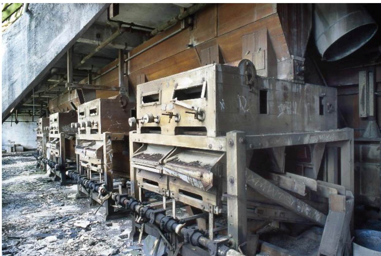
Bâtiment du nettoyage. Deuxième niveau de comble, sasseurs (?).
