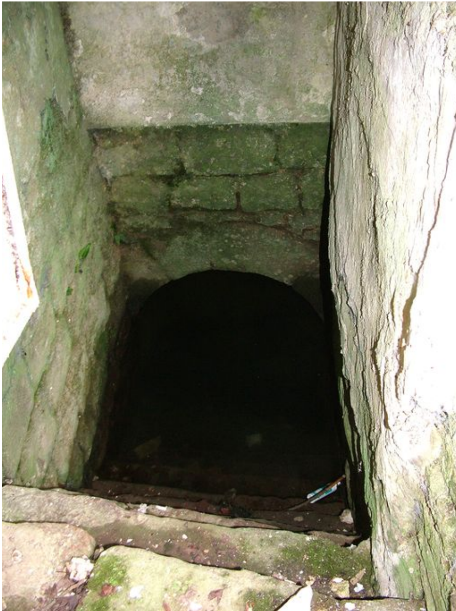
Escalier d'accès à la fontaine.
