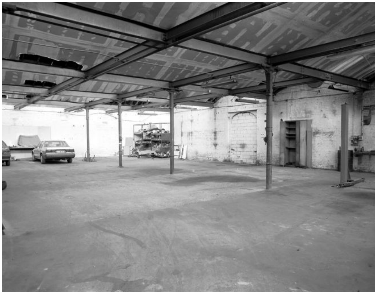
Intérieur de l'atelier de fabrication avec piliers en fonte.
