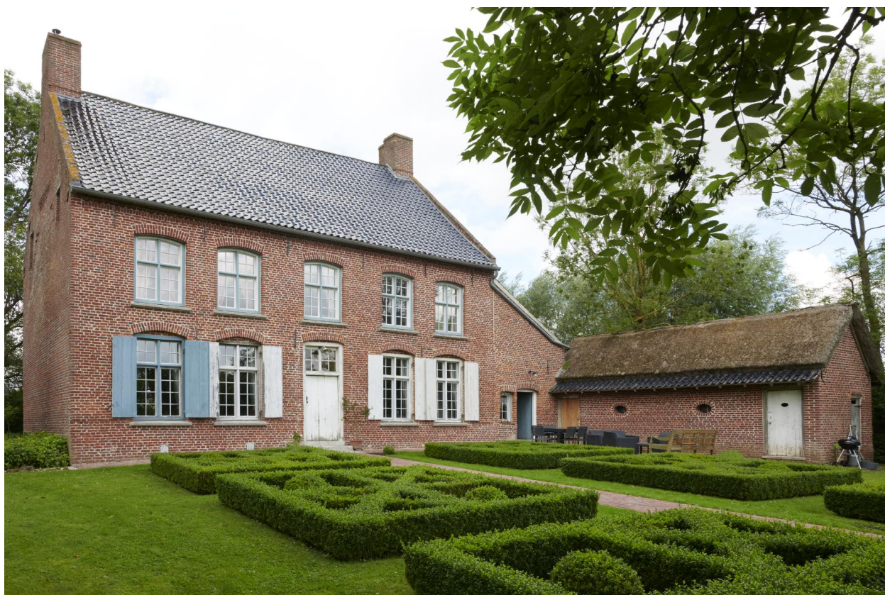
Vue de la façade est et de l'annexe, depuis les jardins.
