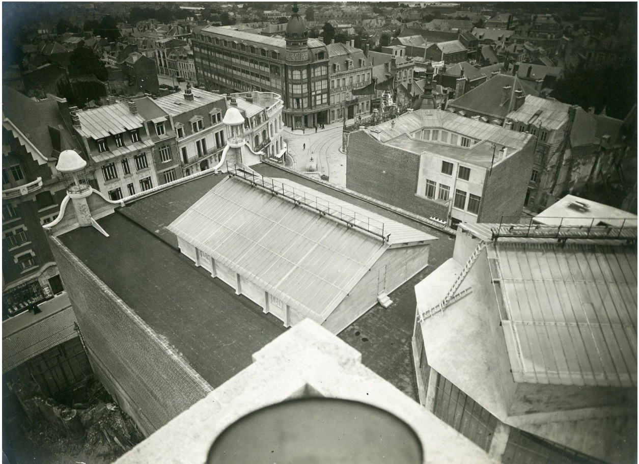
Les toits des Nouvelles Galeries, vers 1925-1926 (Cité de l'Architecture et du Patrimoine ; fonds des Bétons armés Hennebique ; 3-D-372).
