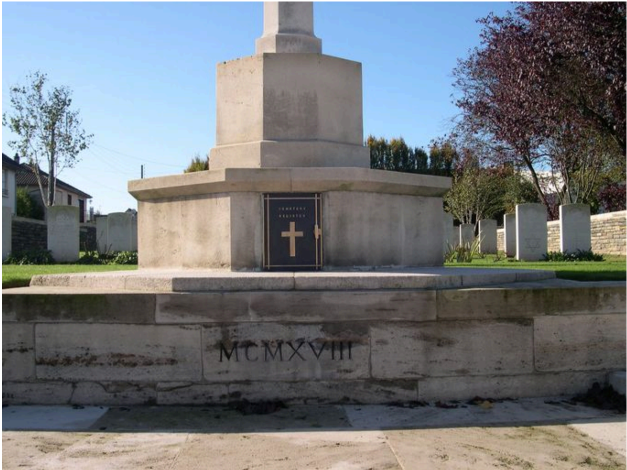
Vue de détail sur la base de la croix du Sacrifice.
