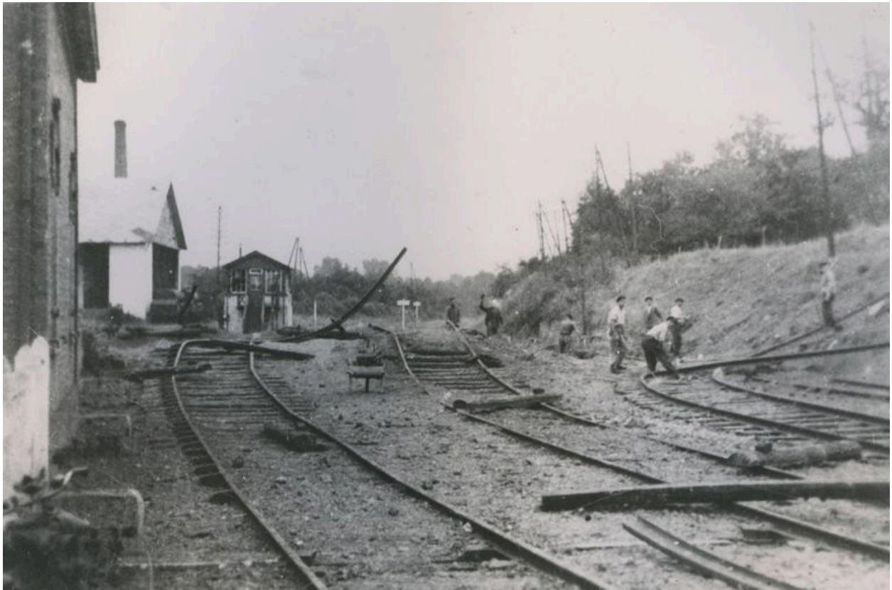
Voies ferrées endommagées par le bombardement du 31 juillet 1944, à proximité de la maison du garde-barrière et de la laiterie (coll. part.).
