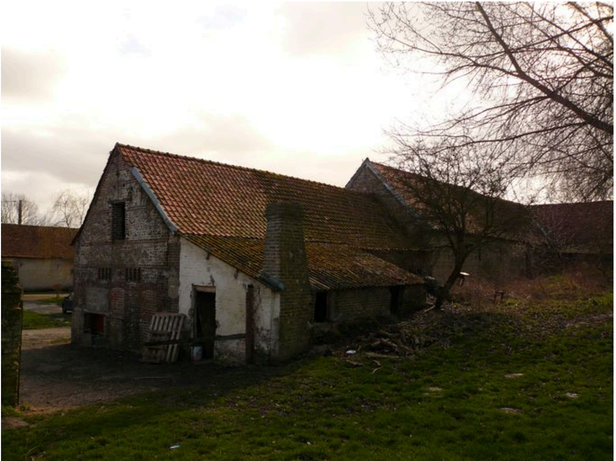
Vue postérieure de la cossetterie.
