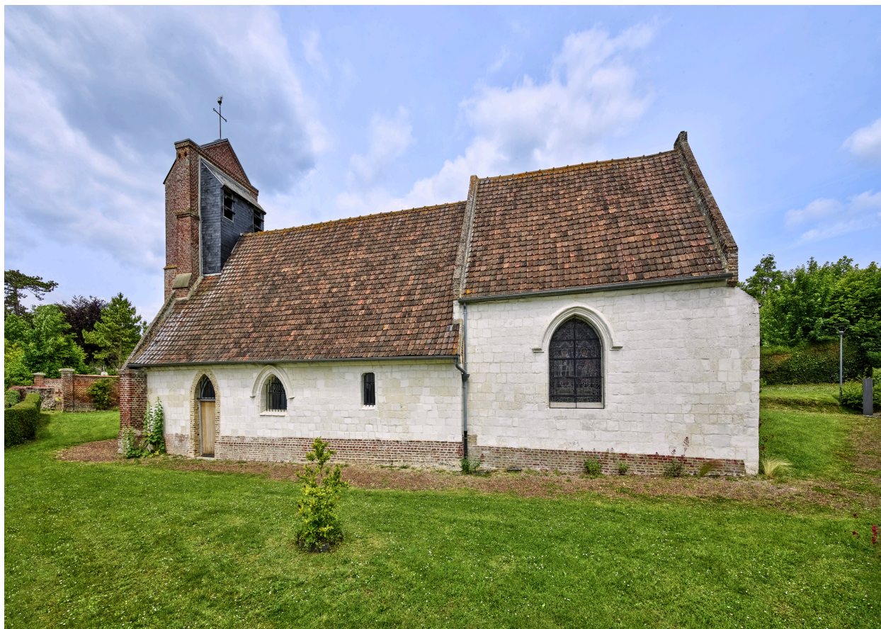
Vue de la façade sud.
