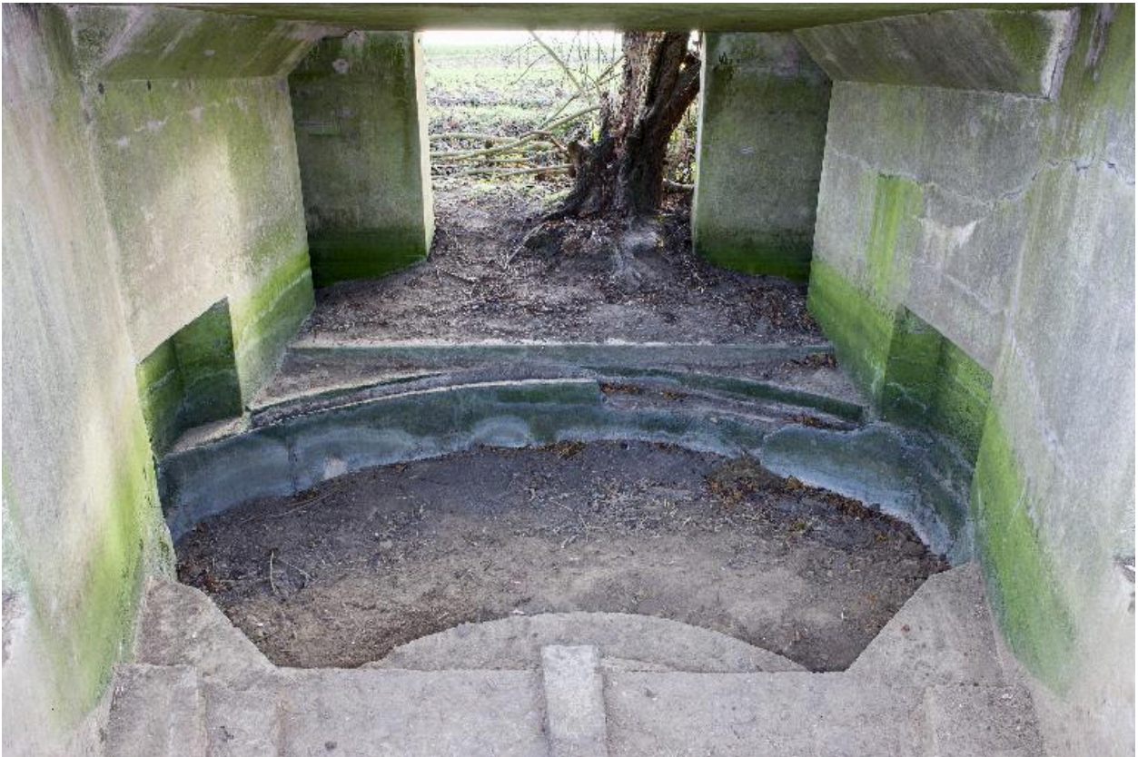
La chambre de tir, vers l'entrée avec, au sol, la plate-forme du canon
