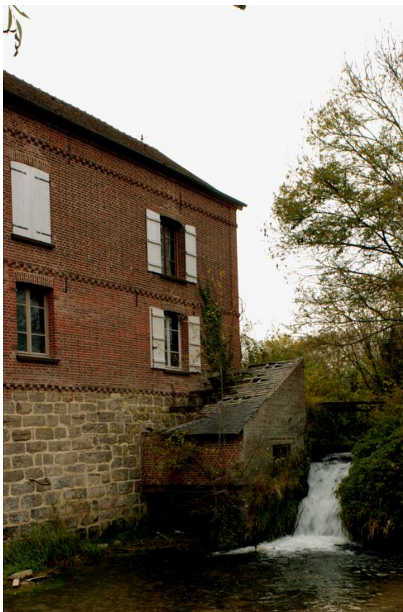
Façade nord du moulin et la chute.
