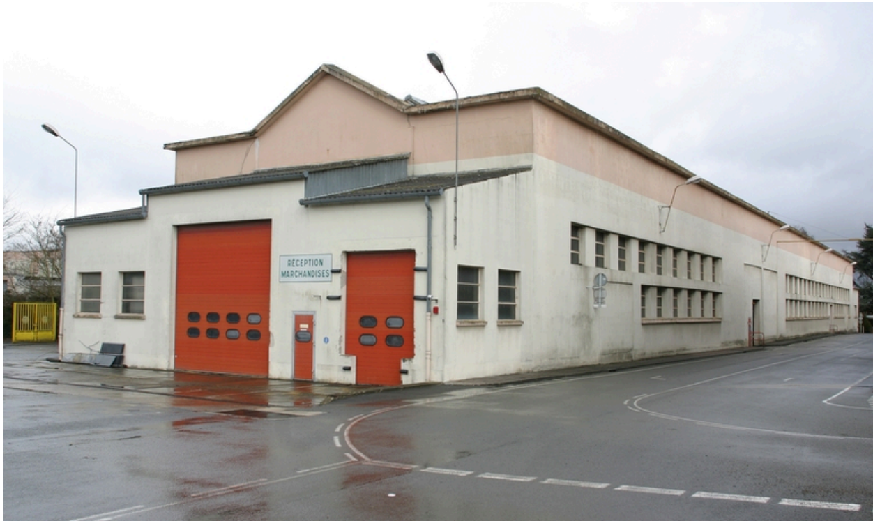
Entrepôt industriel de 1949.
