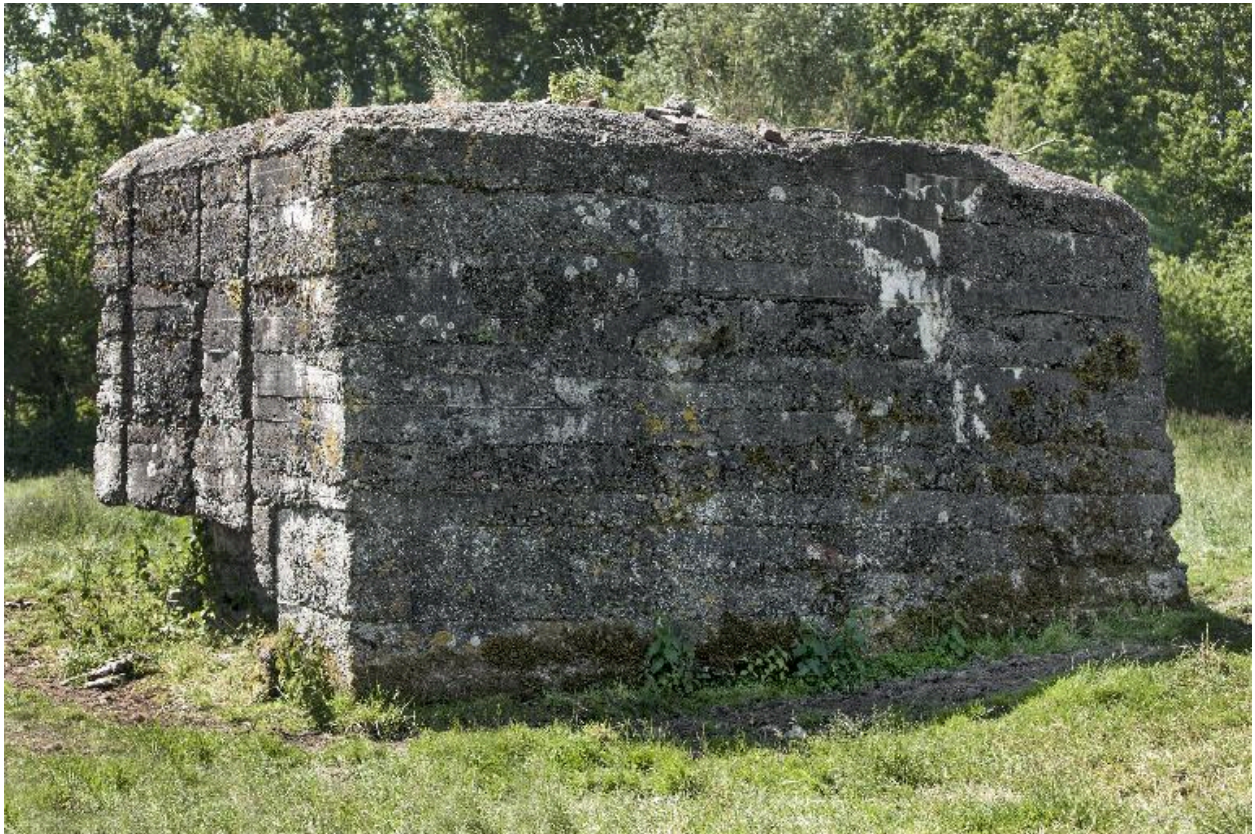
Vue de trois-quarts vers le sud-est
