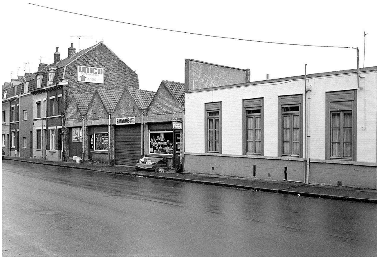
Atelier de fabrication, rue des Quais.
