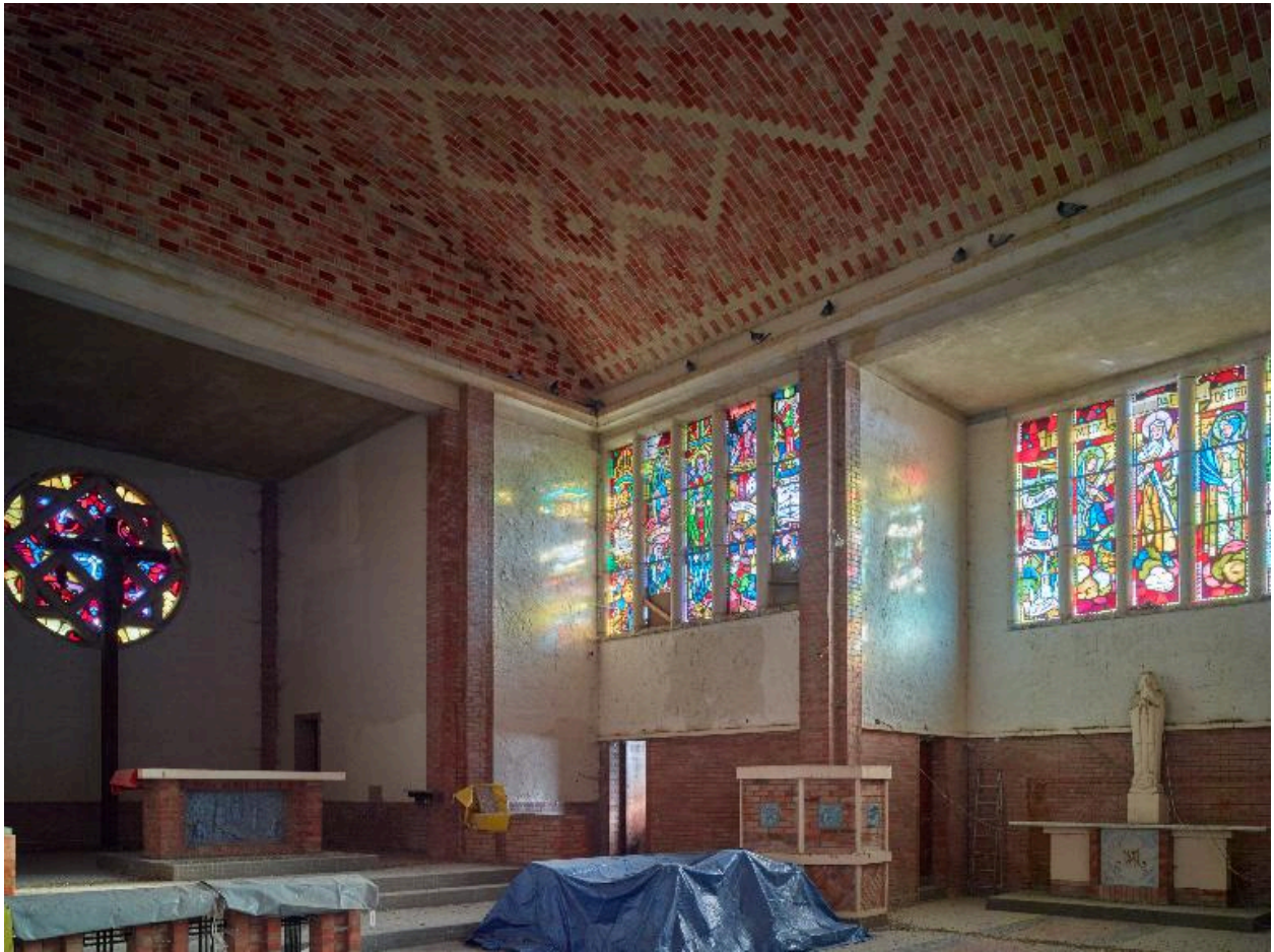
Verrières du transept et du choeur, côté droit
