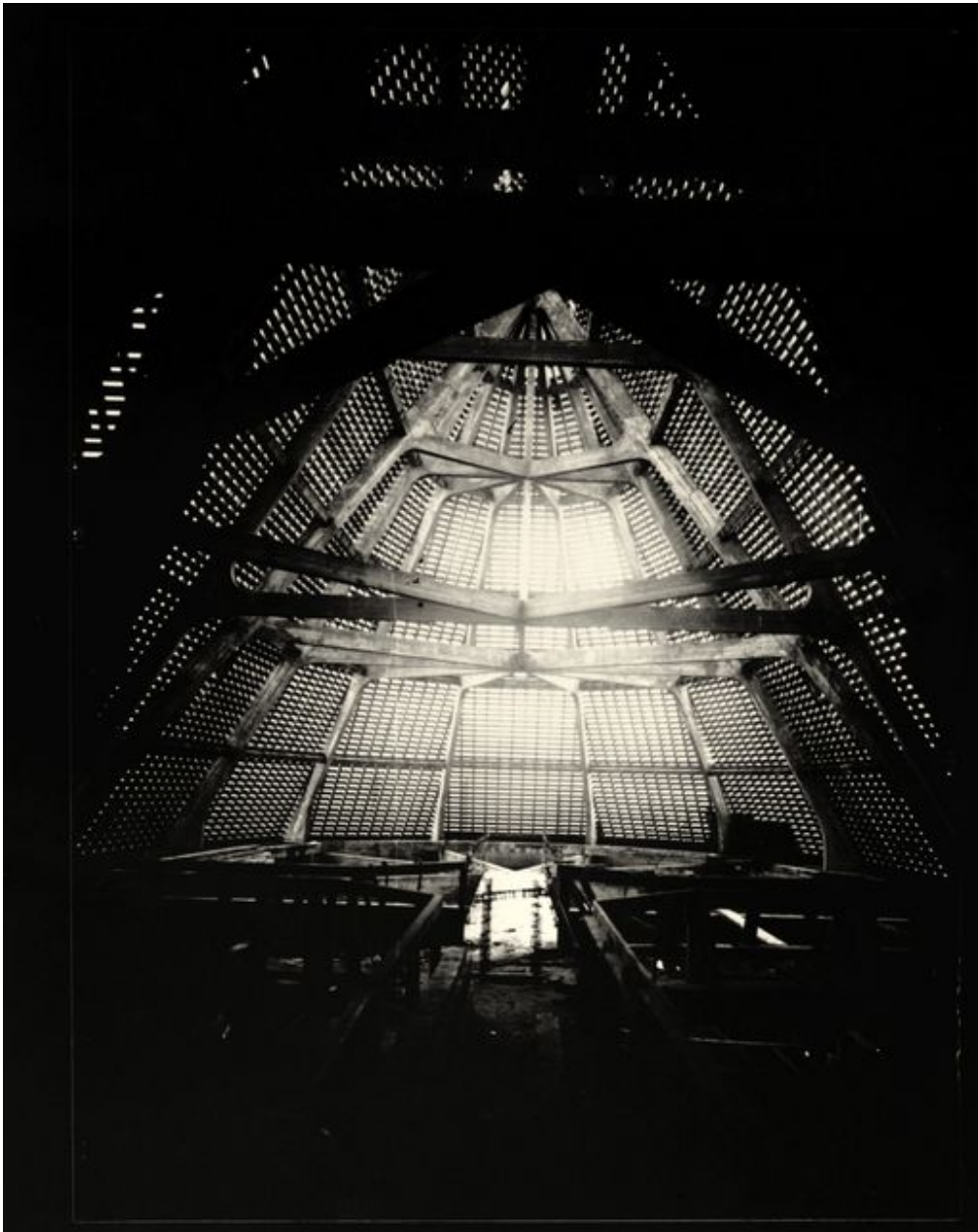
Vue intérieure de la charpente de l'abside, pendant la pose de la couverture (photographie des années trente).
