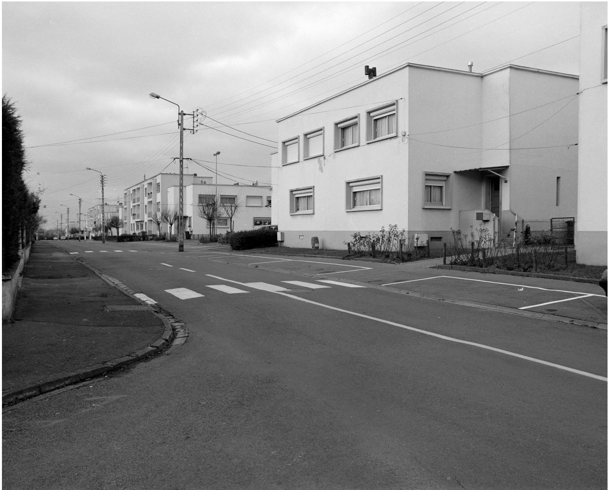
Vue générale depuis la rue (sud).
