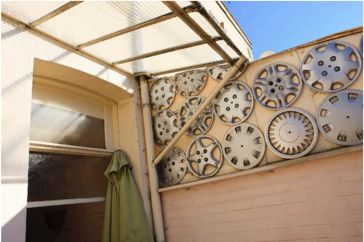
Mur de la véranda, enjoliveurs.
