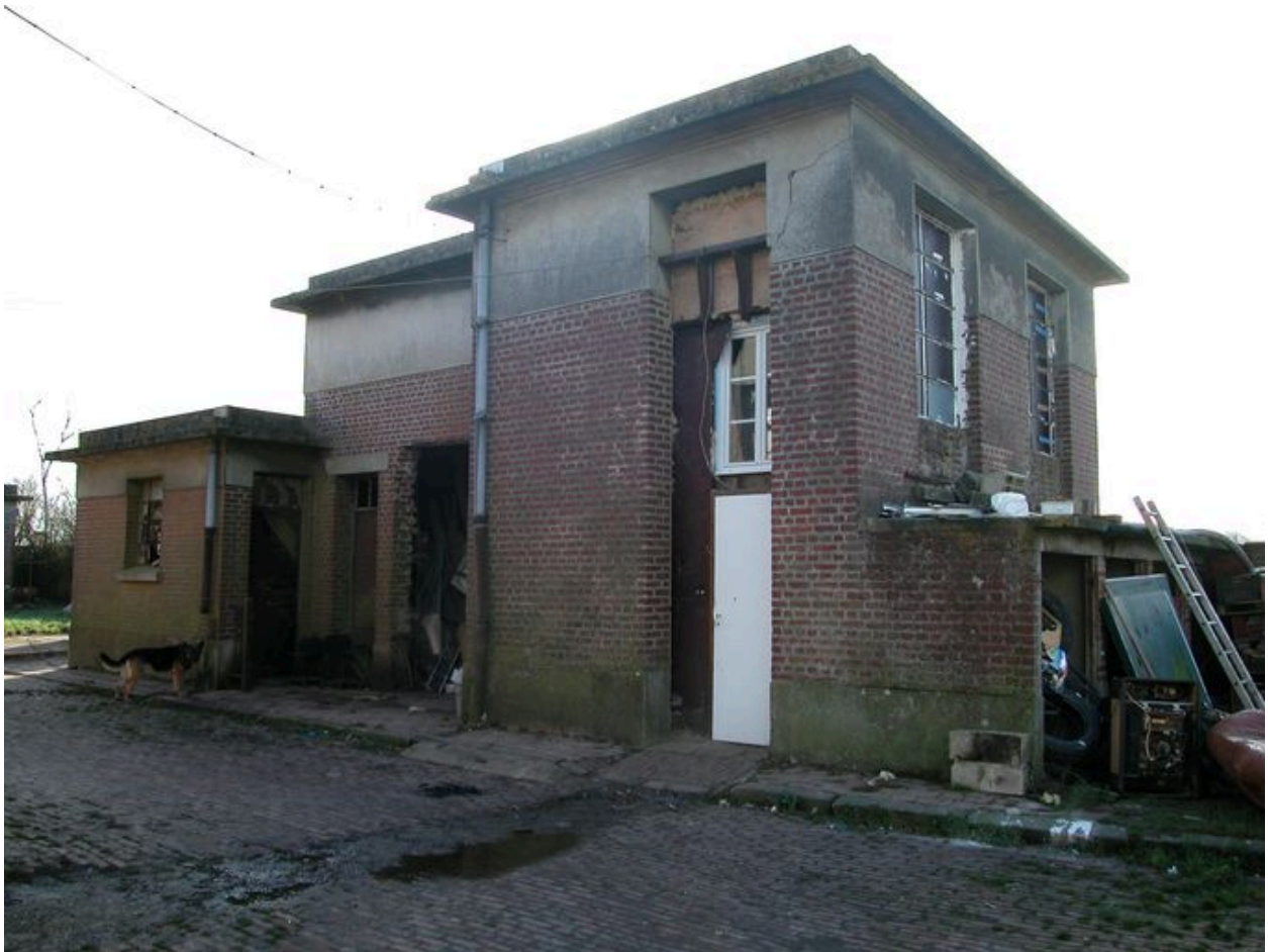
Bâtiment de stockage des viandes.
