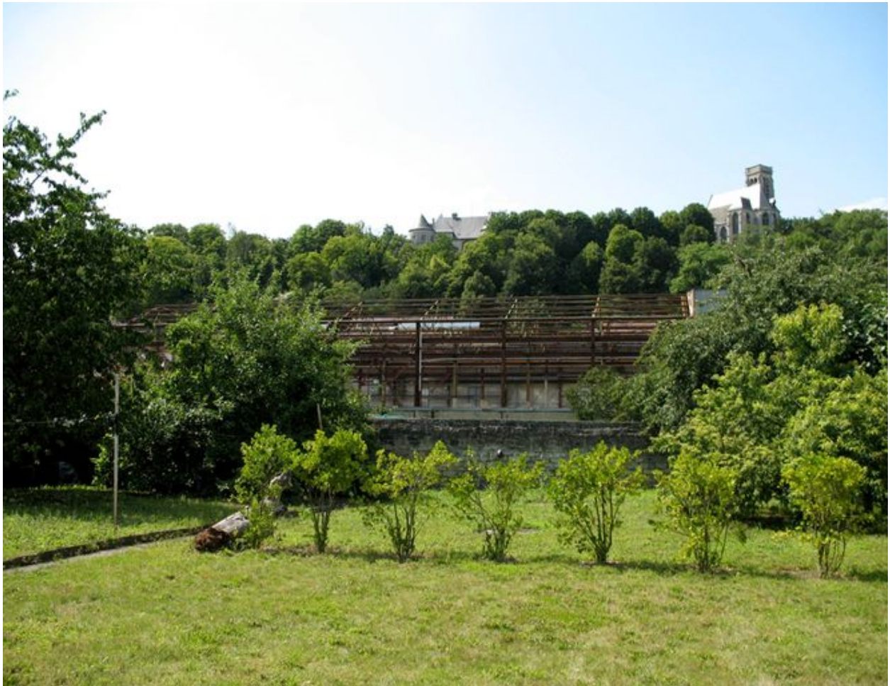
Les ateliers en cours de démolition en juillet 2007, vus vers le nord.
