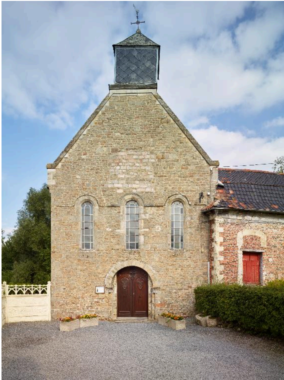
Elévation antérieure de la chapelle.
