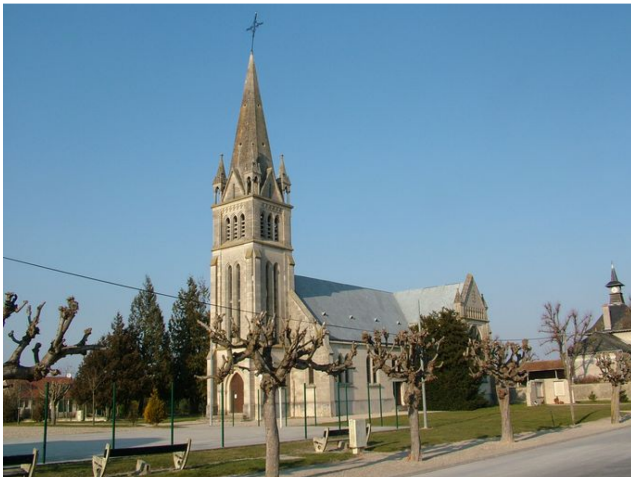
Vue générale de la façade ouest.
